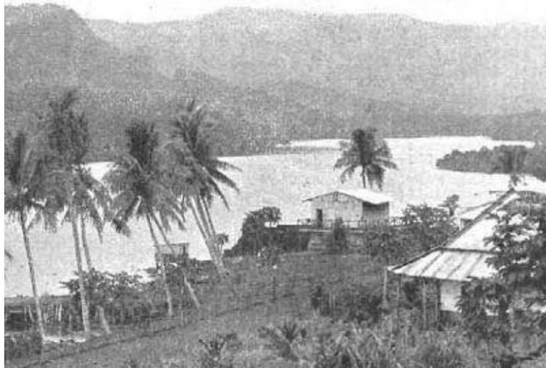
Venta del Río, en la desembocadura en la Rada. Se aprecia el pantalán o embarcadero de piedra. Isla de Ponapé, Carolinas Orientales, en 1899. Foto de La Ilustración Artística.
